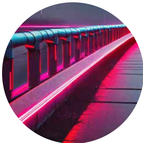
ガードレール
